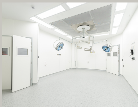
PANEL FENOLIKOA INSTALATZEA
