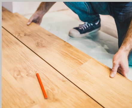
COLOCACIÓN DE SUELOS
