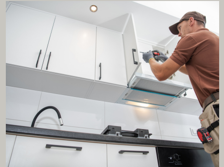
MONTAJE DE COCINAS
